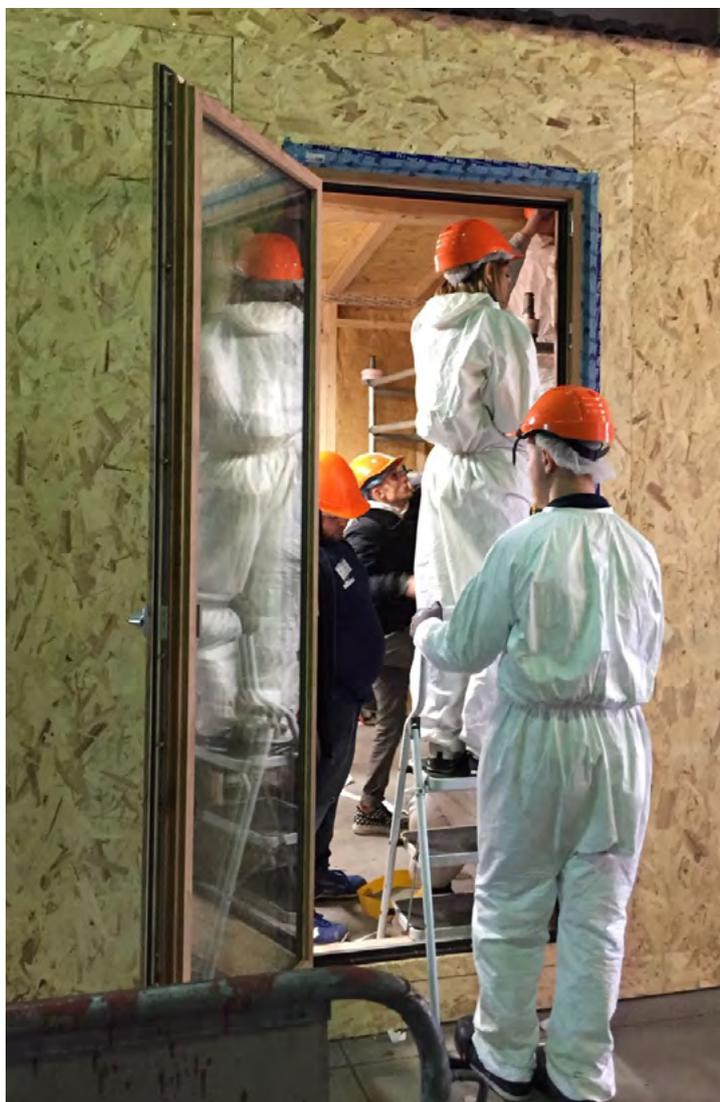
lavoro, hanno successivamente eseguito le prove pratiche relative alla posa dei coibenti, dei teli e della nastratura delle pareti e della copertura e dei serramenti del dimostratore. Una volta terminate tali lavorazioni; gli studenti hanno potuto eseguire il “blower door test” per verificare il livello di tenuta all’aria raggiunto oltre che la qualità del lavoro eseguito.
